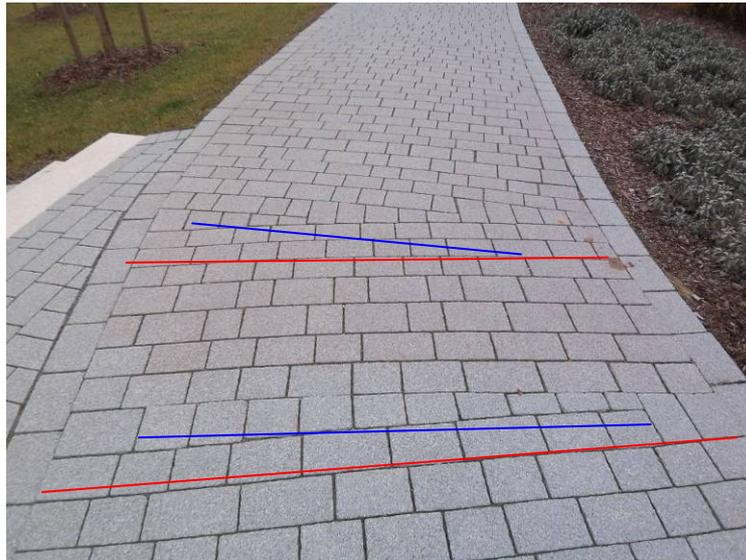
Abbildung 4.16: Gepflasterter Fußweg mit mehrfacher Änderung der Pflasterrichtung an Bruchkanten (rot: alte Richtung, blau: neue Richtung)
