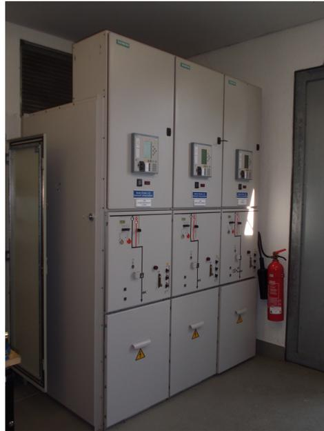
**Abbildung 4.1:** Mittelspannungs-Leistungsschaltanlage (Quelle: Westnetz)
